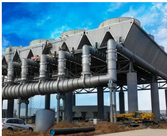
Рисунок 3. «Сухая» градирня шатрового типа
