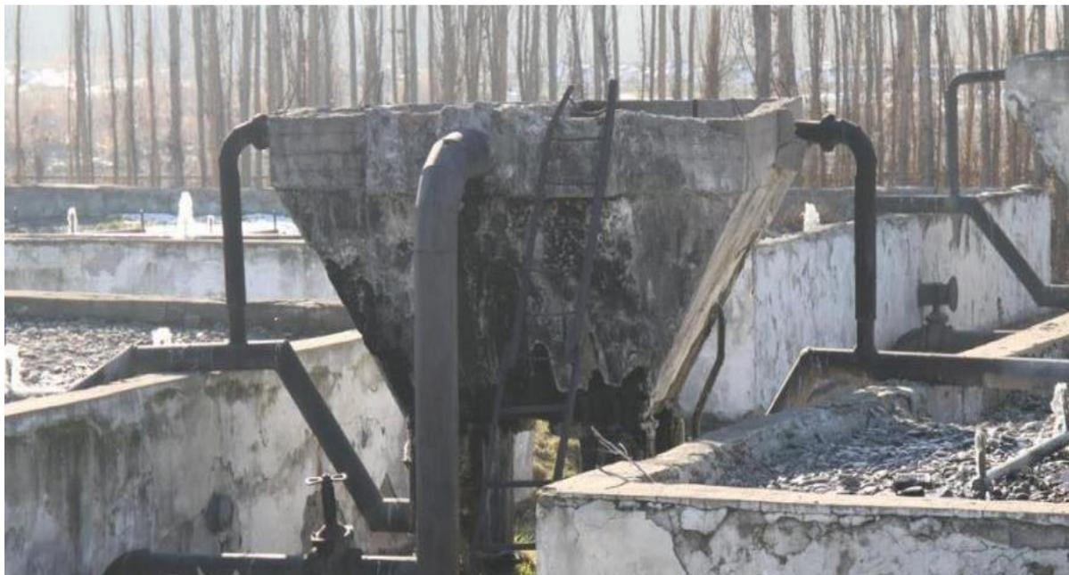
Рис. 4 Распределительная чаша очистных сооружений биологических фильтров города Джалал-Абад
